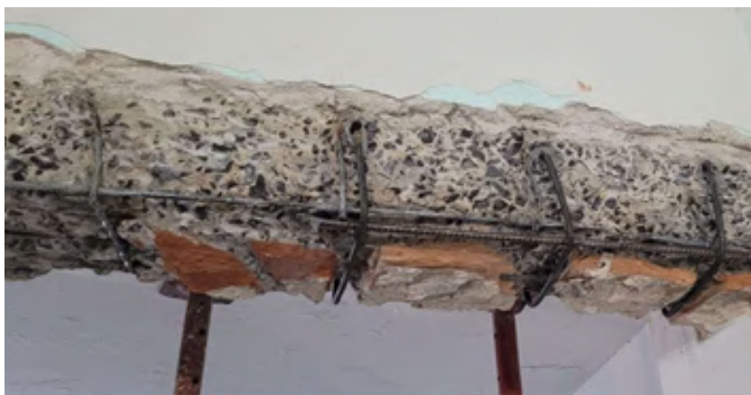
Fotografía 4. Vista de los anclajes de estribos y armadura principal de refuerzos.
