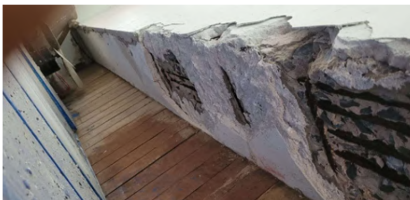
Fotografías 1 y 2. Vista de las vigas con daños por corrosión con propuesta económica de reparación estructural presentada el 31 de mayo de 2024.
