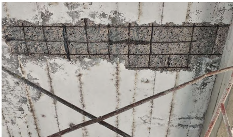
Fotografías 9 y 10. Vista de la escarificación mecánica de la losa del primer nivel.
