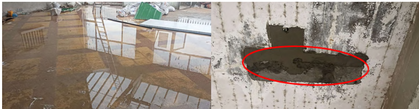
Fotografías 1 y 2. Vista de la acumulación de agua en el nivel 1 y de las filtraciones en la losa que impide la adherencia del mortero de reparación A continuación, se presentan fotografías de los trabajos efectuados;
