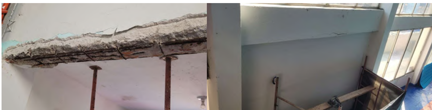
Fotografías 1 y 2. Vista de las vigas con daños por corrosión con propuesta económica de reparación estructural presentada el 31 de mayo de 2024.
