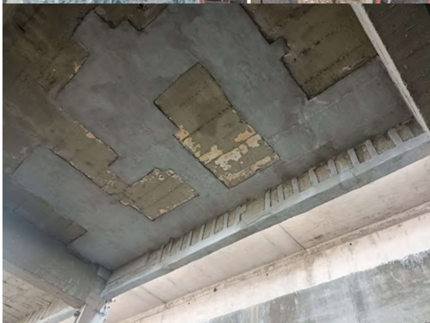
Fotografía 11. Vista de las reparaciones estructurales culminadas en la losa y viga.
