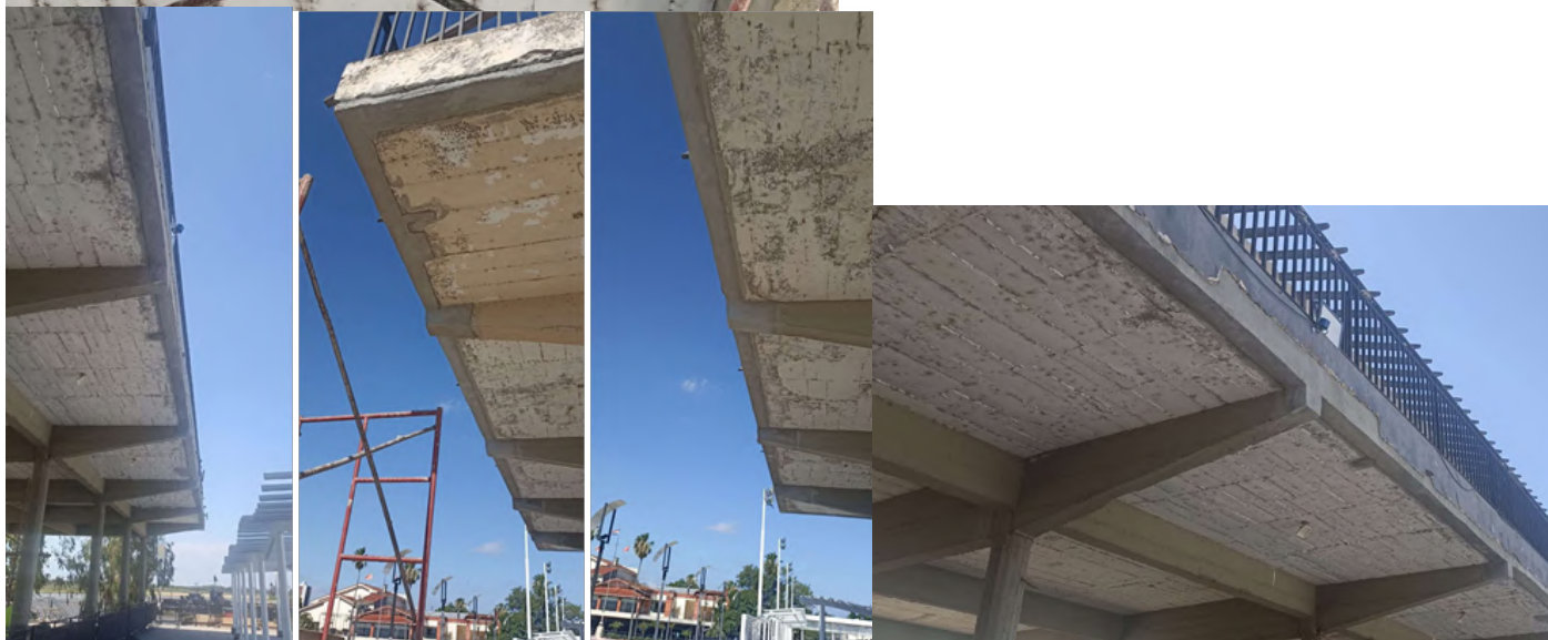
Fotografías 11, 12, 13 y 14. Vista de las reparaciones de las vigas del nivel uno culminada.
