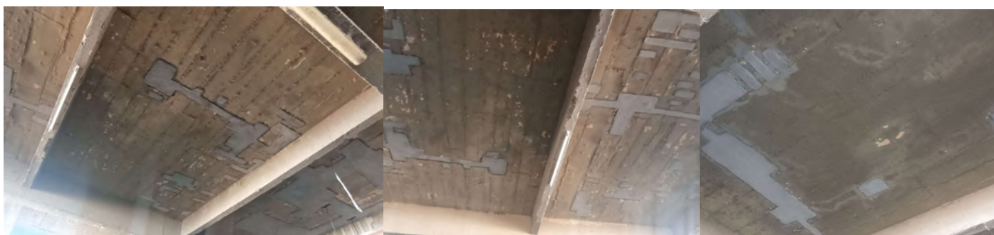
Fotografías 15, 16 y 17. Vista de las reparaciones de las losas de planta baja culminada.
