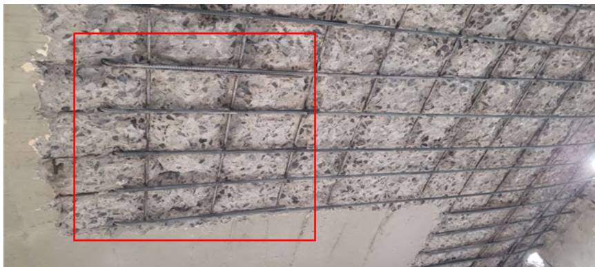
Fotografía 4. Vista de los anclajes de las armaduras de refuerzo.
