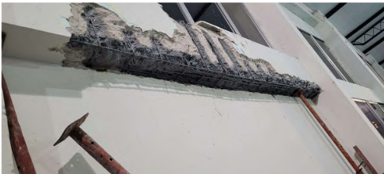
Fotografía 5. Aplicación de puente de adherencia de base epoxi.
