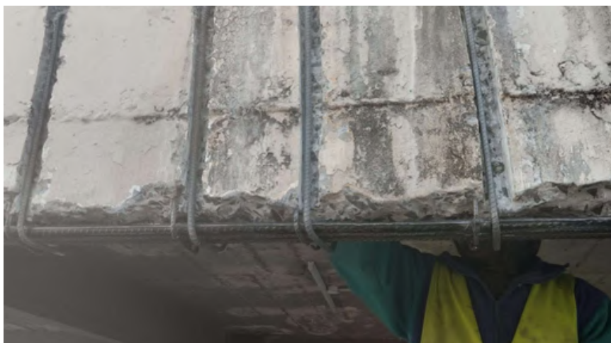
Fotografía 8. Vista de los anclajes de estribos nuevos de refuerzo en la viga intervenida.
