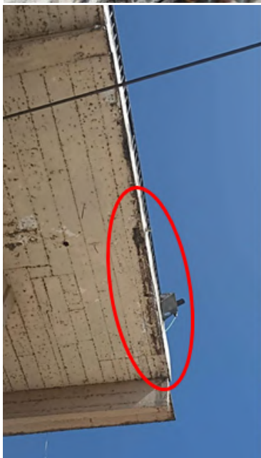
Fotografías 7 y 8. Vista de los daños por corrosión evidenciados en la viga perimetral y de la reparación culminada de esta.
