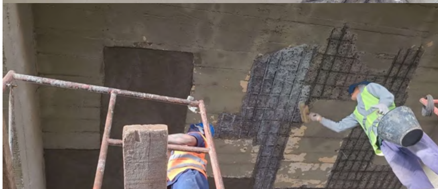
Fotografía 5. Vista de los trabajos de relleno con mortero de reparación de la losa intervenida.
