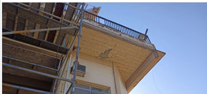
Fotografías 7 y 8. Vista de los daños por corrosión evidenciados en la viga perimetral y de la reparación culminada de esta.
