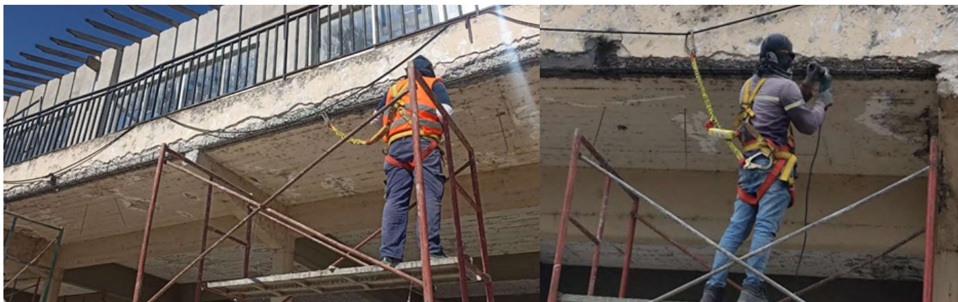
Fotografías 3 y 4. Vista de la escarificación mecánica y limpieza de armaduras en la viga perimetral externa en el nivel 1.
