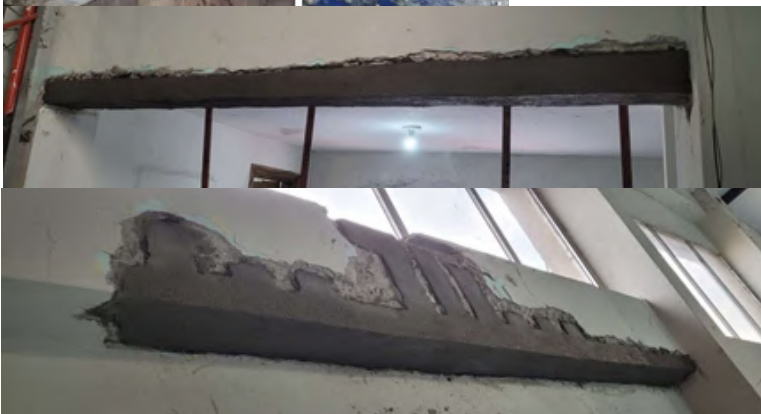
Fotografías 6 y 7. Vista posterior a los trabajos de limpieza de armaduras y aplicación del pasivador.
