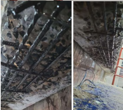
Fotografías 6 y 7. Vista posterior a los trabajos de limpieza de armaduras y aplicación del pasivador.
